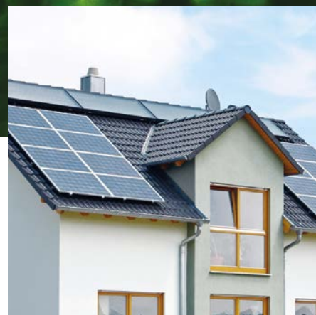
MODUŁY I INWERTERY FOTOWOLTAICZNE
